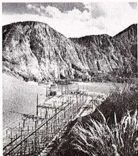
Le barrage : une digue de 120 m. de haut, épaisse de 650 m. à la base.
